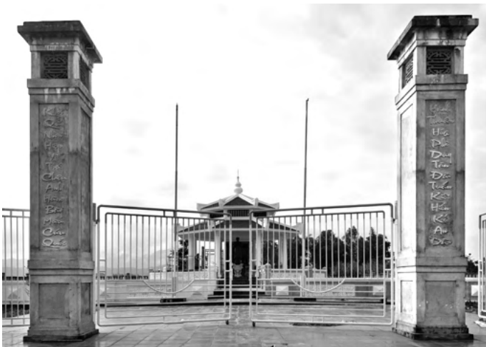
Khu tưởng niệm chí sỹ Trần Cao Vân do con cháu tộc Trần Công xây dựng tại quê nhà thôn Phú Đông, xã Điện Quang, thị xã Điện Bàn, tỉnh Quảng Nam.
